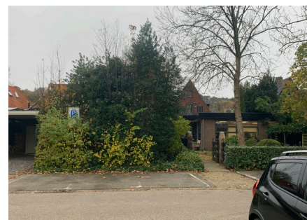
Enkele voorgevels richting de parkeerplaats
