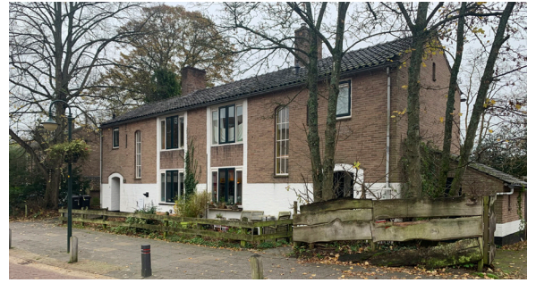
Karakteristieke woningen aan de Duinvoetweg
