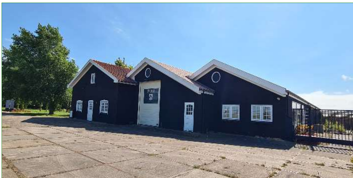
Vooraanzicht van de betreffende bedrijfsloodsen, gemaakt vanuit het noorden.
