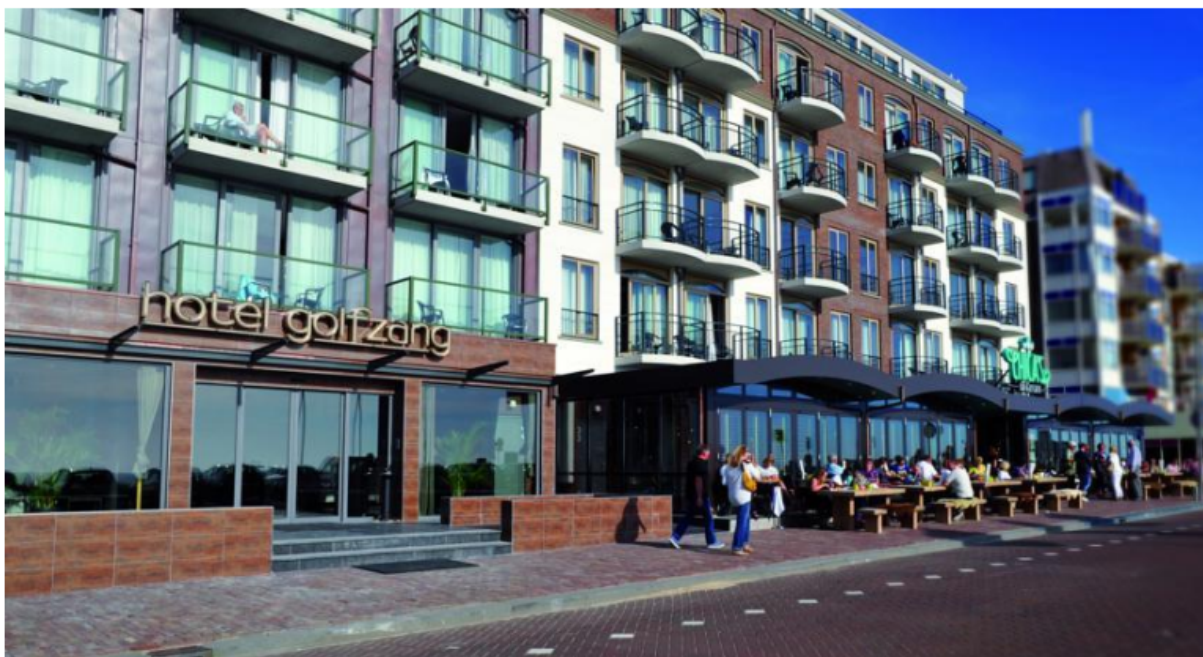
Afbeelding 3. Bestaande situatie hotel Golfzang fase I, zeezijde
