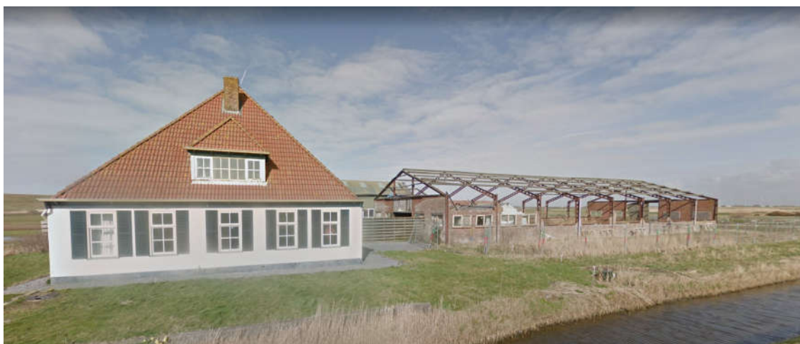
Afbeelding 2.2: Foto aanzicht vanaf de Kamperkade, de bedrijfsgebouwen zijn inmiddels volledig gesloopt.
