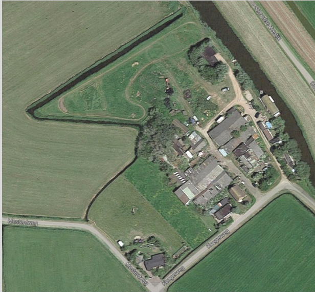
Bestaande situatie Koogerweg 1 (e.o.); vervallen bebouwing op voormalig agrarisch erf
