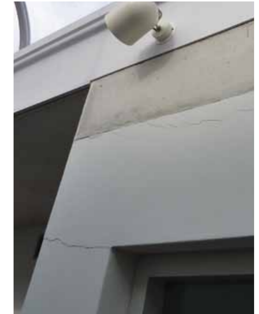
foto 3,4 Diverse (thermische) scheurvorming in wanden t.p.v. verdieping. Mogelijke oorzaak: spanningsverschil tussen beton en onderliggende metselwerk ten gevolge van temperatuurverschillen onder de lichstraat.
