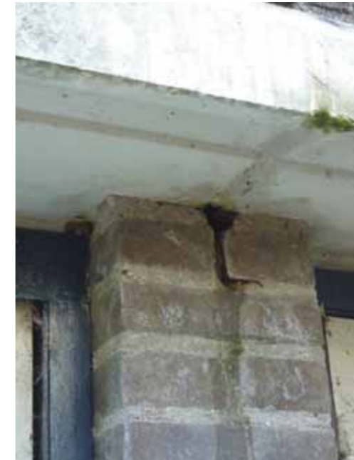
foto 20,21 Ter plaatse van metselwerkdilataties en penanten komt lekwater achter het metselwerk vandaan, hetgeen betekent dat de schil lek is. Huidige metselwerk is verstevigd met r.v.s. ankers tegen 'wegschuiven'. Er is tevens sprake van vorstschade van het metselwerk.
