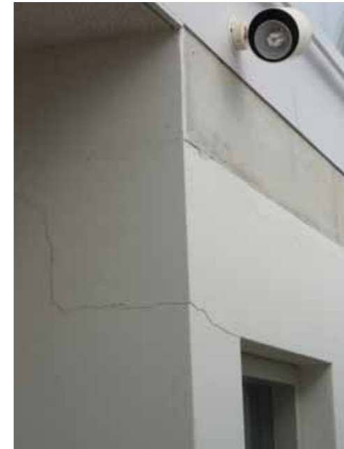
foto 3,4 Diverse (thermische) scheurvorming in wanden t.p.v. verdieping. Mogelijke oorzaak: spanningsverschil tussen beton en onderliggende metselwerk ten gevolge van temperatuurverschillen onder de lichstraat.
