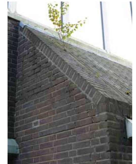
foto 25,26 Op de kopse zijdes van het schuine metselwerkgedeelte is de gevel ontzet en komt los van het overige metselwerk.
