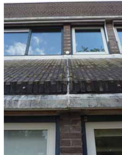
foto 20,21 Ter plaatse van metselwerkdilataties en penanten komt lekwater achter het metselwerk vandaan, hetgeen betekent dat de schil lek is. Huidige metselwerk is verstevigd met r.v.s. ankers tegen 'wegschuiven'. Er is tevens sprake van vorstschade van het metselwerk.
