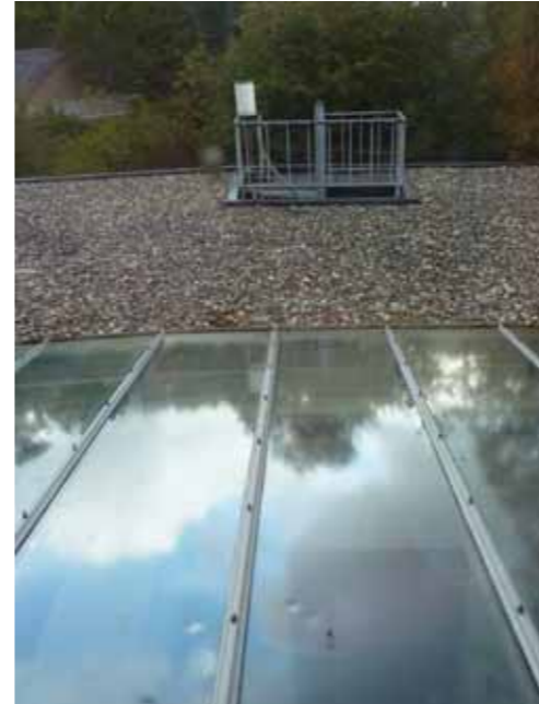
foto 12 Afwatering daklichten is aandachtspunt.
