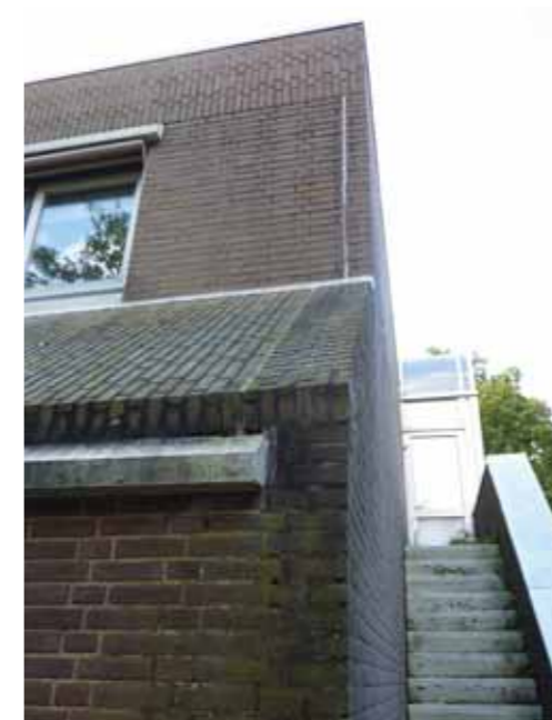
foto 25,26 Op de kopse zijdes van het schuine metselwerkgedeelte is de gevel ontzet en komt los van het overige metselwerk.
