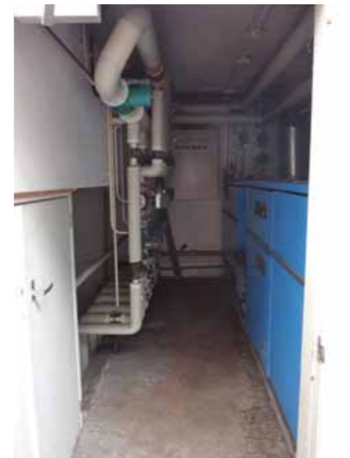
foto 9,10 - Installatietechniek. De luchtbehandeling is gepositioneerd in de kelder onder de raadszaal. De CV installatie is verouderd. De positie van deze verwarmingsinstallatie is decentraal, namelijk de 1e verdieping van de noordvleugel. Voor details over de huidige staat verwijzen we naar het rapport van BVI.
