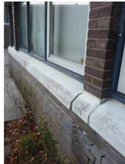
foto 20,21 Ter plaatse van metselwerkdilataties en penanten komt lekwater achter het metselwerk vandaan, hetgeen betekent dat de schil lek is. Huidige metselwerk is verstevigd met r.v.s. ankers tegen 'wegschuiven'. Er is tevens sprake van vorstschade van het metselwerk.
