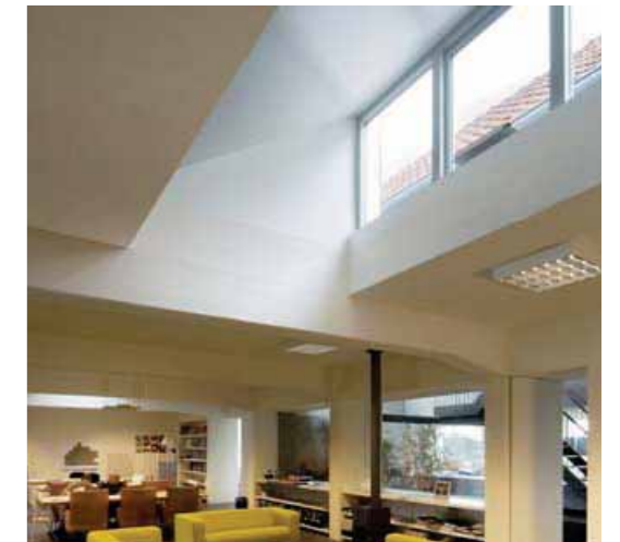
vervangen huidige daklichten door incidentele lichthappers
