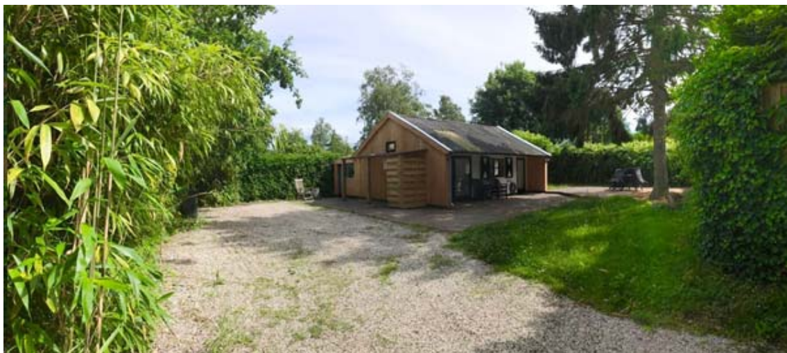
Figuur 2.2 Foto huidige situatie met bestaand bouwwerk annex nachtverblijf
