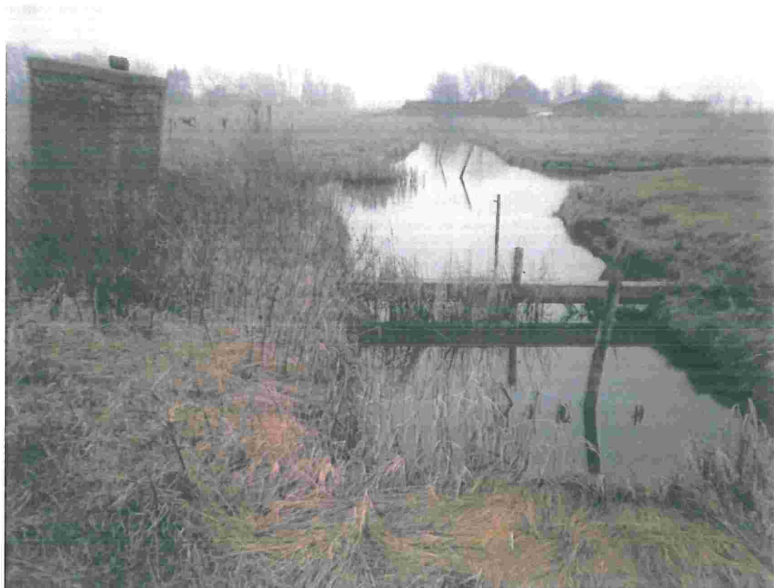
Figuur 2. De locatie waar de dam met duiker wordt vervangen, gezien in zuidelijke richting. De foto is genomen vanaf de te verwijderen dam. De nieuwe dam wordt ca. 8 m zuidelijk van de huidige aangelegd, dus vlak achter de betonnen balk over de sloot. .
