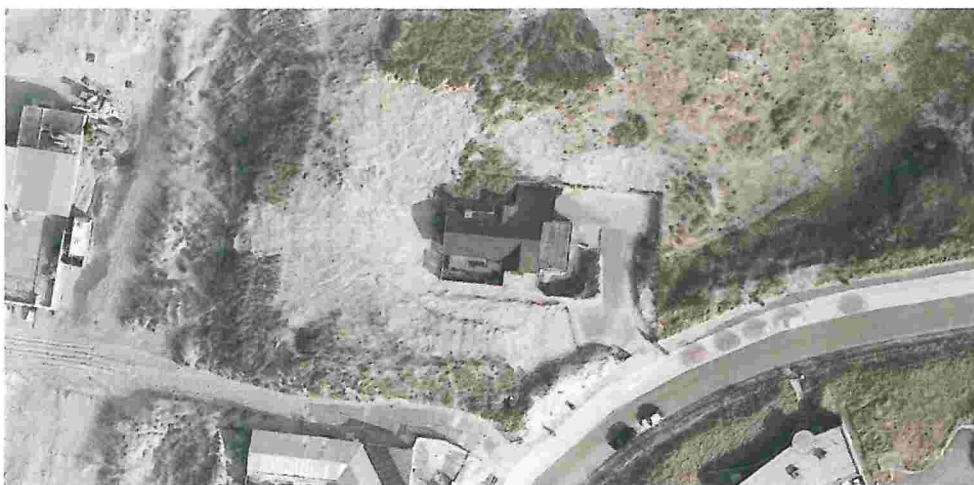
Figuur 5: Luchtfoto C.F. Zeiler Boulevard 7
