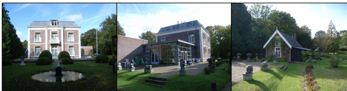
Figuur 2 Voorzijde villa, aanbouw achterzijde en bijgebouw
