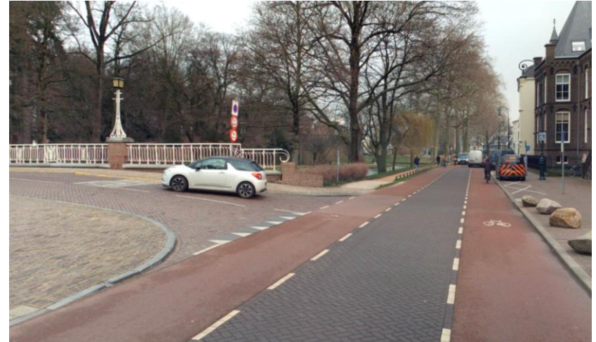
Voorbeeld profiel gebiedsontsluitingsweg 30 km/h met rijloper in klinkers en brede fietsstroken in asfalt
