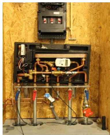
Figuur 6 - Links: Een binnenunit van een warmtepomp met boiler , rechts: een afleverzet
