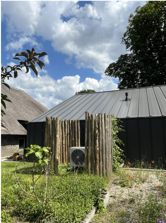
Figuur 9 - Voorbeeld van geluidswering buitenunit warmtepomp.
