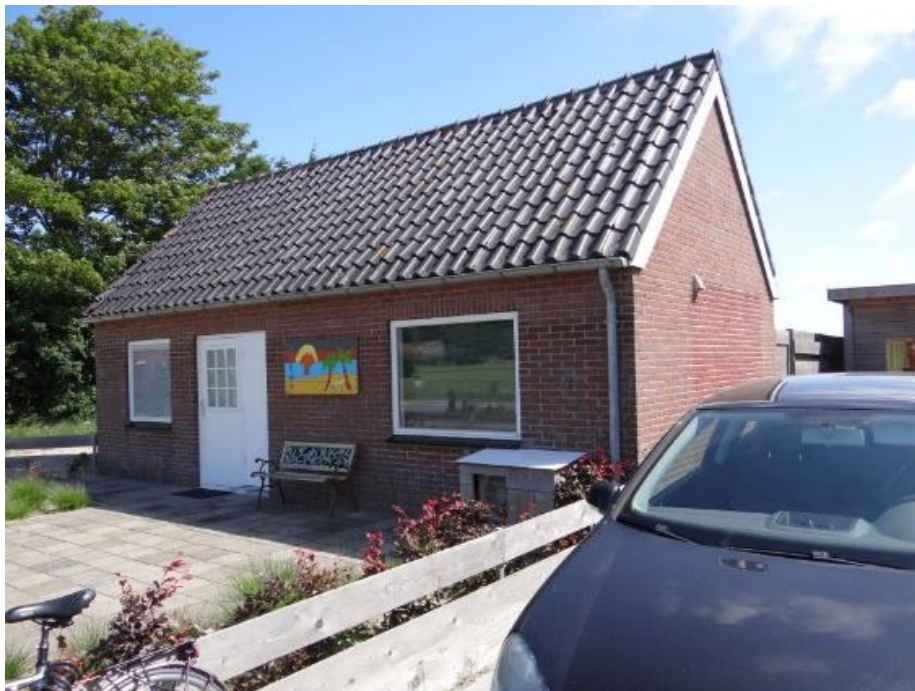
Foto 1. Het bestaande gebouw op de planlocatie, zicht op de voorzijde (Herenweg).
