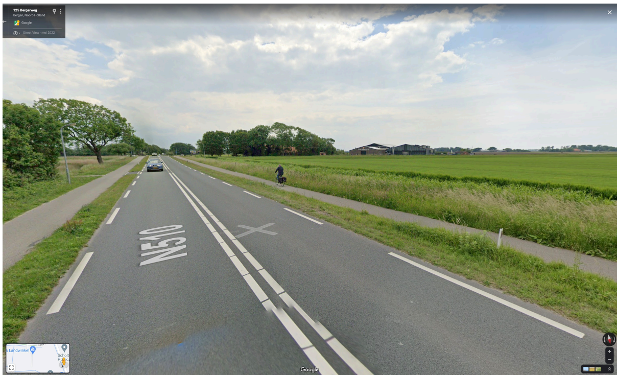
zicht op de strandvlakte zuidelijker langs de Bergerweg, ensembles van bebouwing, met en zonder groene omwalling
