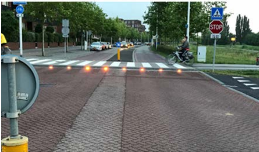
Bijlage 5: foto van aanvullende maatregelen met plateau, stopgebod en knipperlichten om de veiligheid te verbeteren
