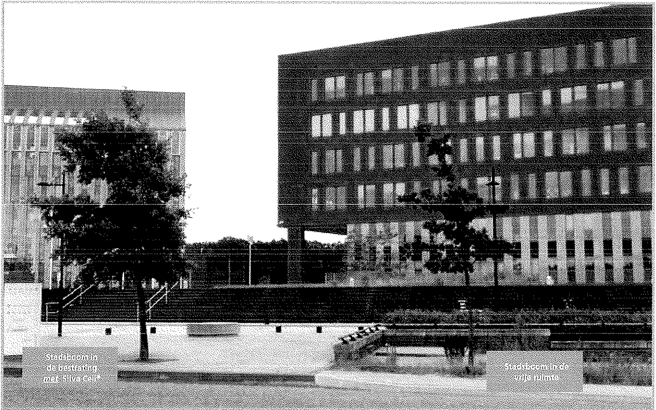
Project in Amersfoort, 5 jaar na installatie Silva Cell®
