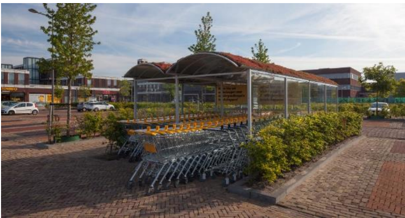
Winkelwagens onder groen dak | Granieten boombank
