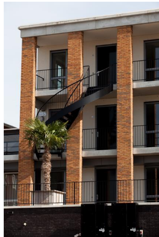
Galerij met bakstenen penanten
