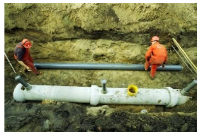
Figuur 2 Gescheiden rioolstelsel (RIONED)
