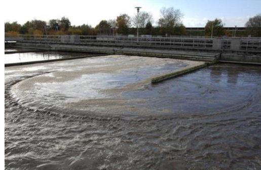
Figuur 1 Rioolwaterzuiveringsinstallatie (RIONED)
