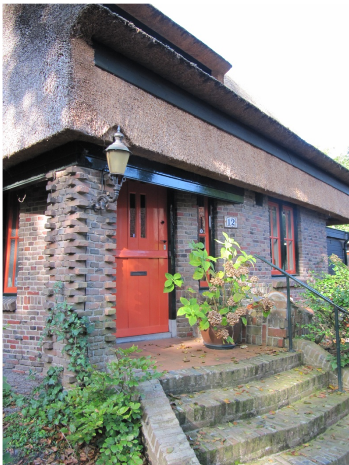
Rechter zijgevel met entree achter stoep en gemetselde kolom op de hoek met de voorgevel
