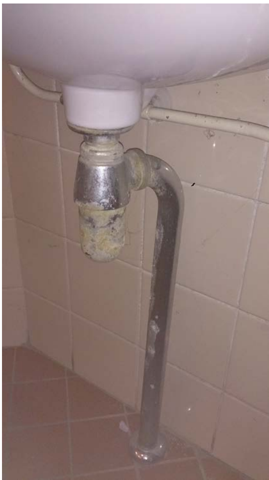
Vloerbuizen en sifonpotten vervangen
