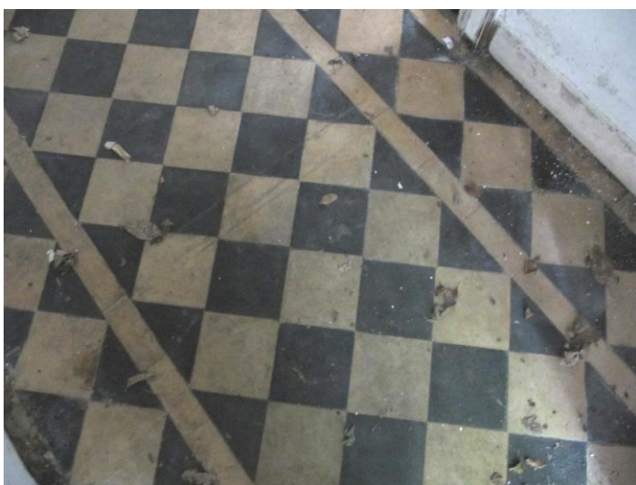
11. Interieur: plavuizen in middencorridor
