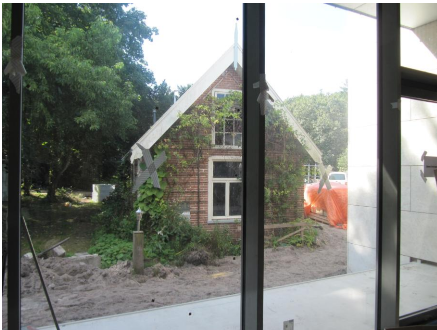
13. Zicht op de kopgevel vanuit de nieuwbouw
