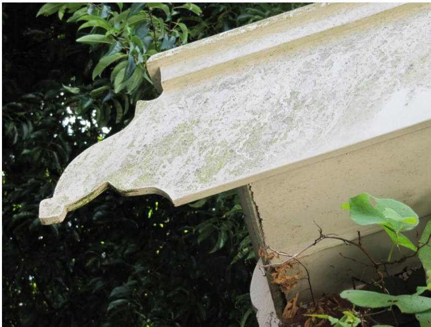
7. Geprofileerde windveer kopgevel
