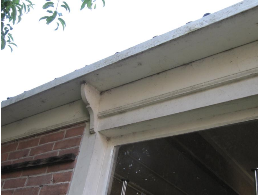
8. Oijefvormige gootklos onder blokgoot in voorgevel
