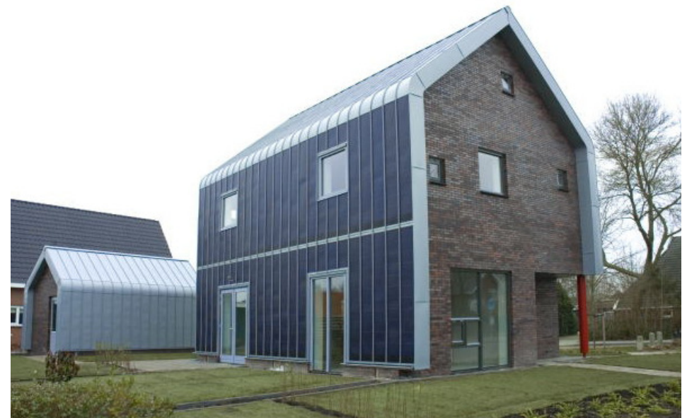
Duurzame energie: zonnepanelen
