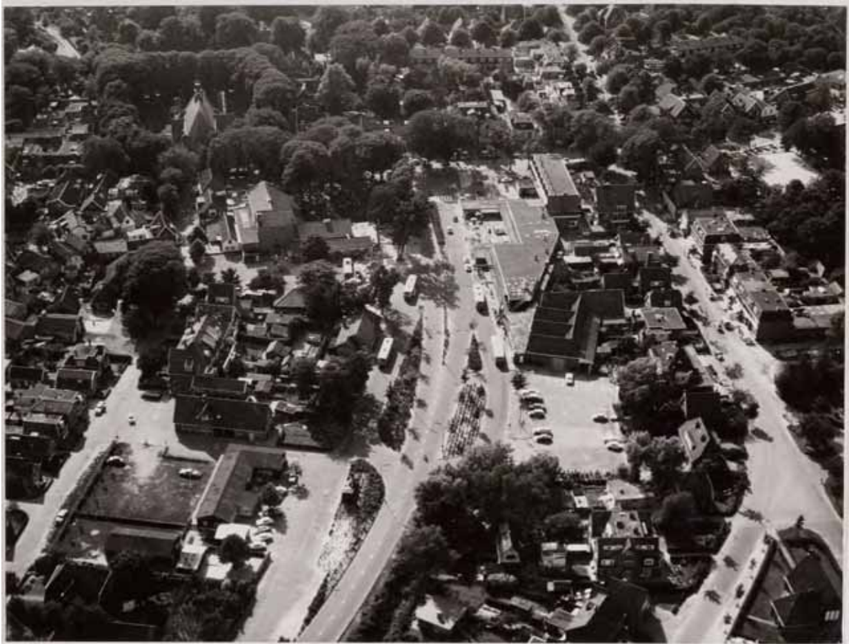
Afbeelding 21 Luchtfoto genomen voor de sloop van de kolenloodsen. In één oogopslag is duidelijk hoe groot het gat is tussen de beide groene, kleinschalige dorpschelften.
