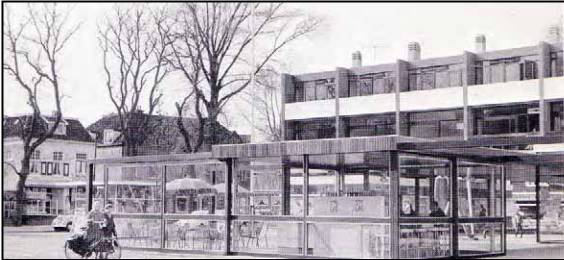
Afbeelding 12 Ideaalbeeld van de Bakemaflat als protagonist op het toneel tegen een decor van oudbouw en beplanting. De bomenrij, die de historische route naar het noorden markeert, is tegenwoordig onderbroken (Joedicke).
