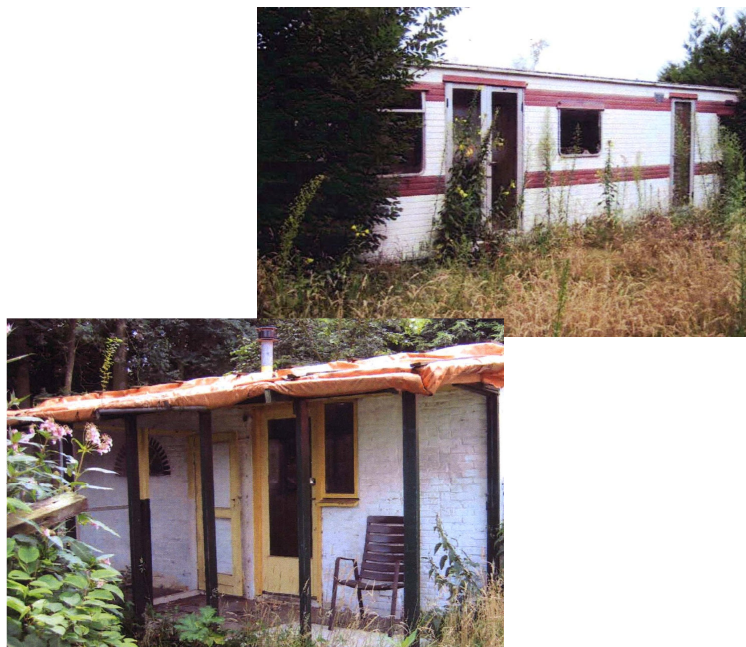
Figuur 2. Indruk van de gesloopte dan wel verwijderde bouwwerken (Bron: Leeuwenkamp Architecten BV, 2008)
