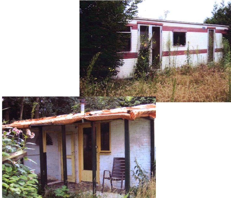
Figuur 2. Indruk van de gesloopte dan wel verwijderde bouwwerken (Bron: Leeuwenkamp Architecten BV, 2008)
