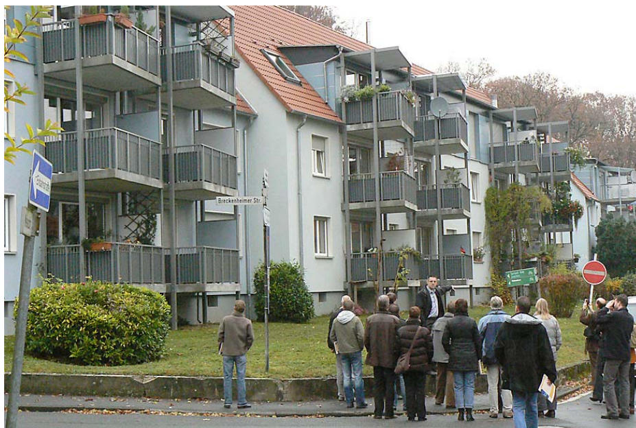
Excursie Renovatieprojecten op passiefhuis niveau in Duitsland
