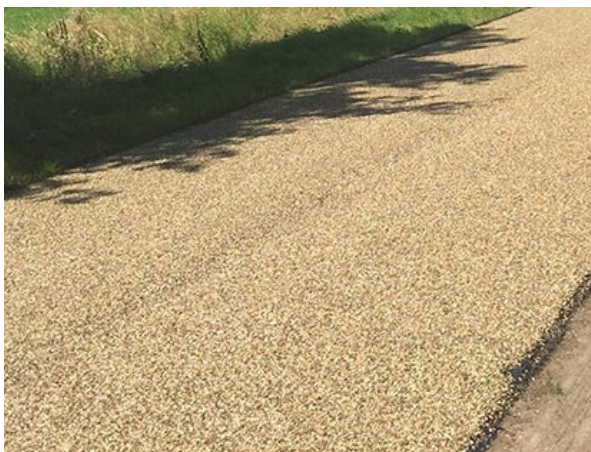
Asfalt met slijtlaag van split geeft landelijk beeld en is onderhoudsvrij
